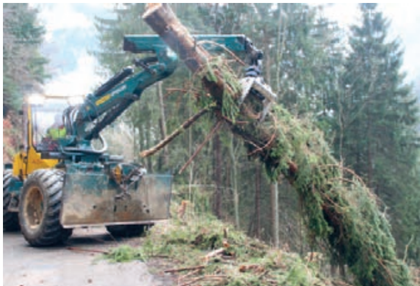
Cantiere ad alta meccanizzazione in Austria, su terreni molto pendenti (uso dello skidder).
