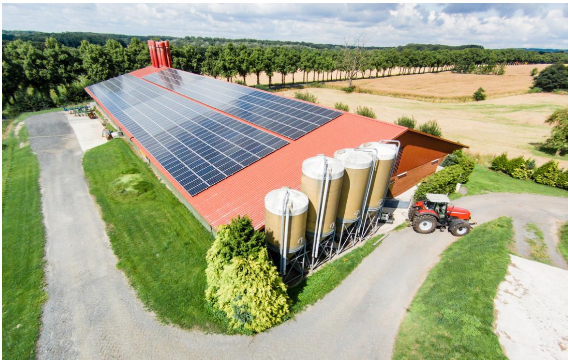
PARCO AGRISOLARE = FOTOVOLTAICO SU FABBRICATI
